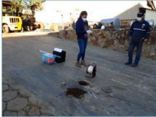
Reparación, desarrollo y análisis de pozo de monitoreo de agua subterránea. (Taller de Automotores)
